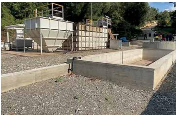
Il vecchio sistema fognario convogliava i reflui in mare senza alcun trattamento, mediante 2 condotte sottomarine. Con il nuovo impianto di depurazione e di collettamento della frazione Marina, realizzato attraverso la totale ristrutturazione di due stazioni di sollevamento e la realizzazione di due nuove stazioni, più un impianto compatto a tecnologia MBR, il Comune di Camerota punta a candidarsi alla bandiera blu d'Europa 2021.
