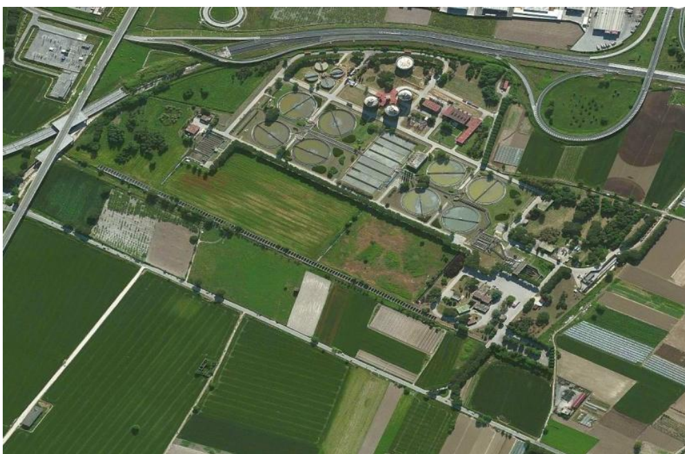
Figura 12 - Depuratore Napoli Nord – (fonte: Bing Maps)
