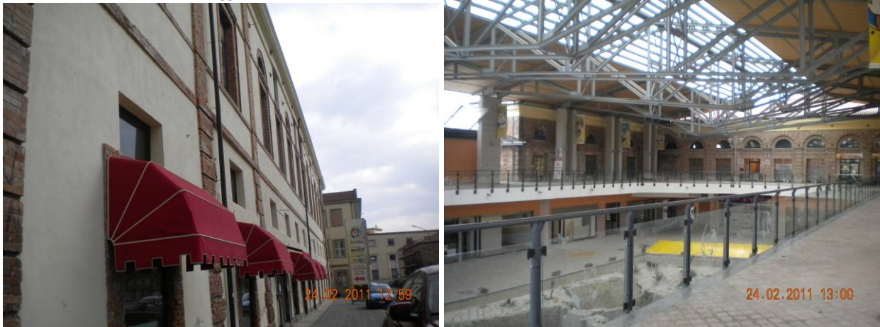
Figg. 28 e 29 -Mercato dei commestibili, esterno e interno (fonte: NVVIP)
