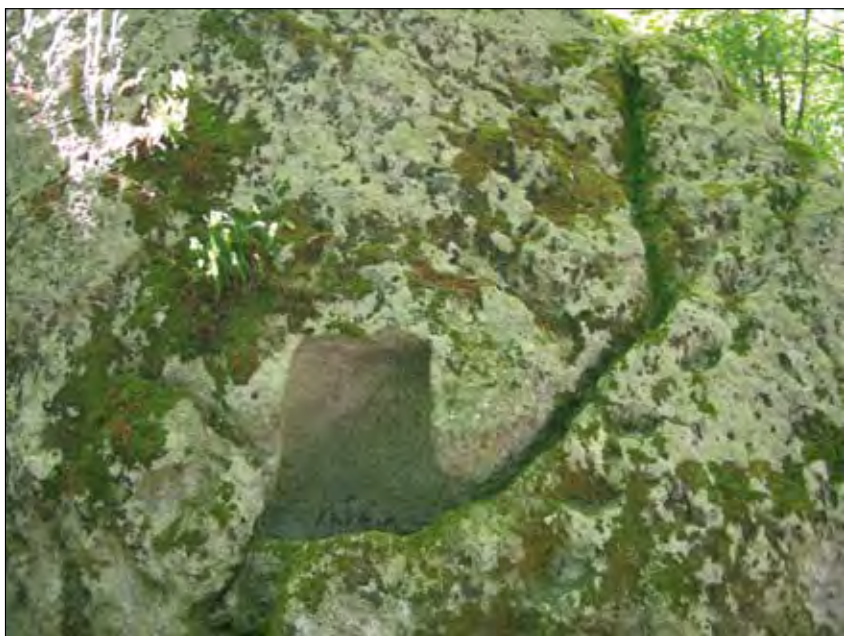
Fig. 34 - Canaletto scavato nel masso per il convogliamento delle acque piovane in cisterna.
