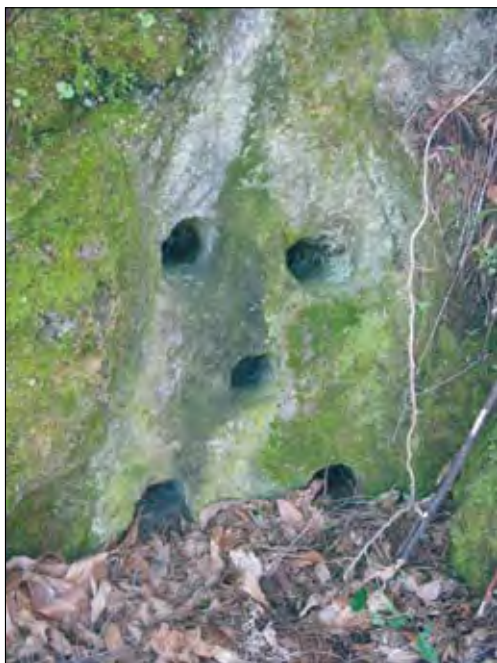
Fig. 22 - Fori di ventilazione di un cellaio (Ventarole).
