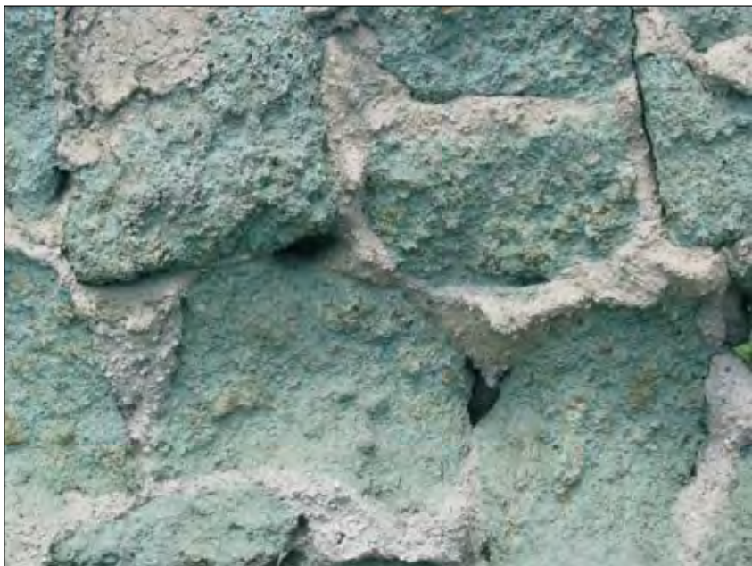
Fig. 6 - Muratura in tufo verde legata a malta.
