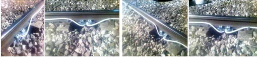
**Figura 2** – Tipica installazione lungo la rotaia dei sensori in fibra ottica integrati nei package.
