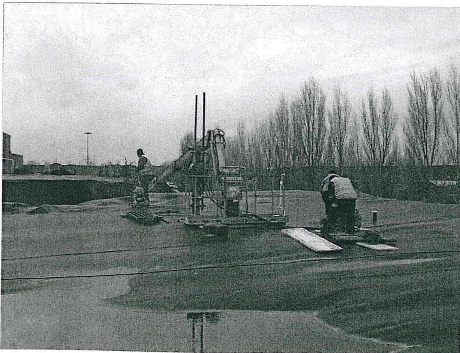
Fig. 3 - Operazioni di approntamento attrezzatura di perforazione
