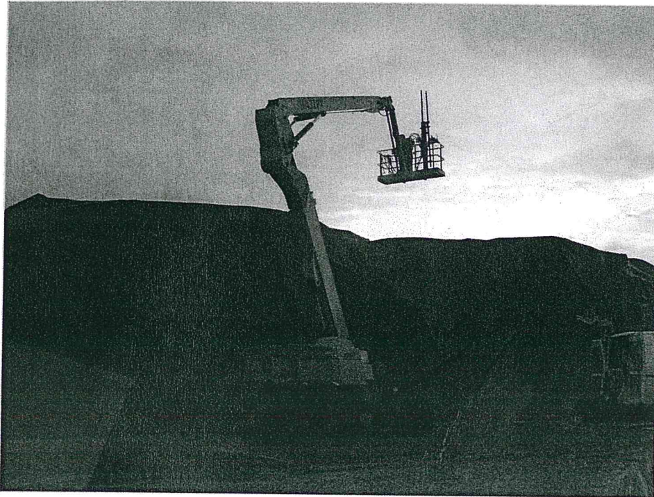
Fig. 2 - Operazioni di posizionamento
