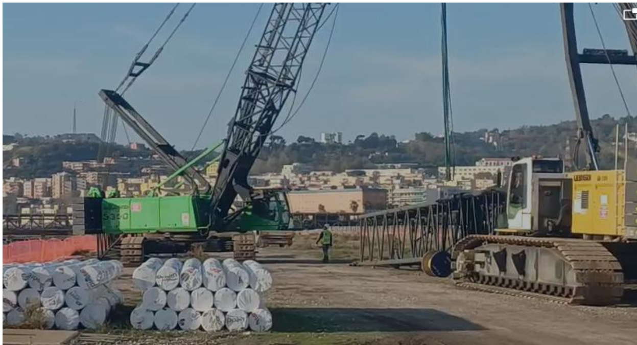
Figura 6 – I macchinari di cantiere
