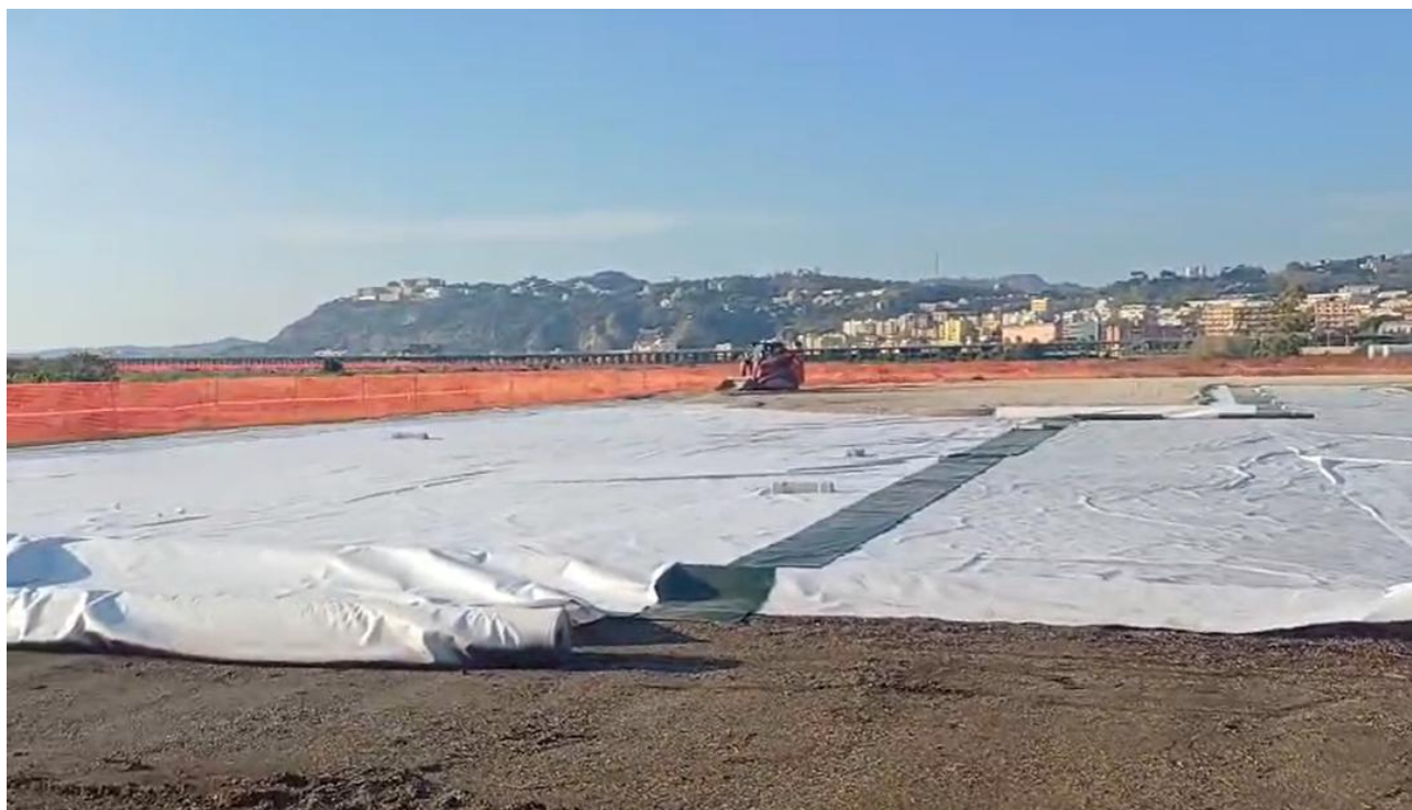
Figura 3 – Attività di predisposizione del cantiere delle opere a mare
