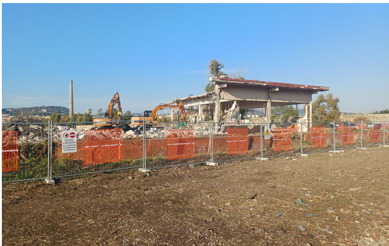
Figura 4 – Demolizioni in corso nel cantiere sulla colmata
