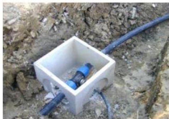
Pozzetto rete percolato in PEHD con giunzione a T
