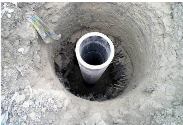
Particolare del pozzo di aspirazione e camini per l'eliminazione del biogas
